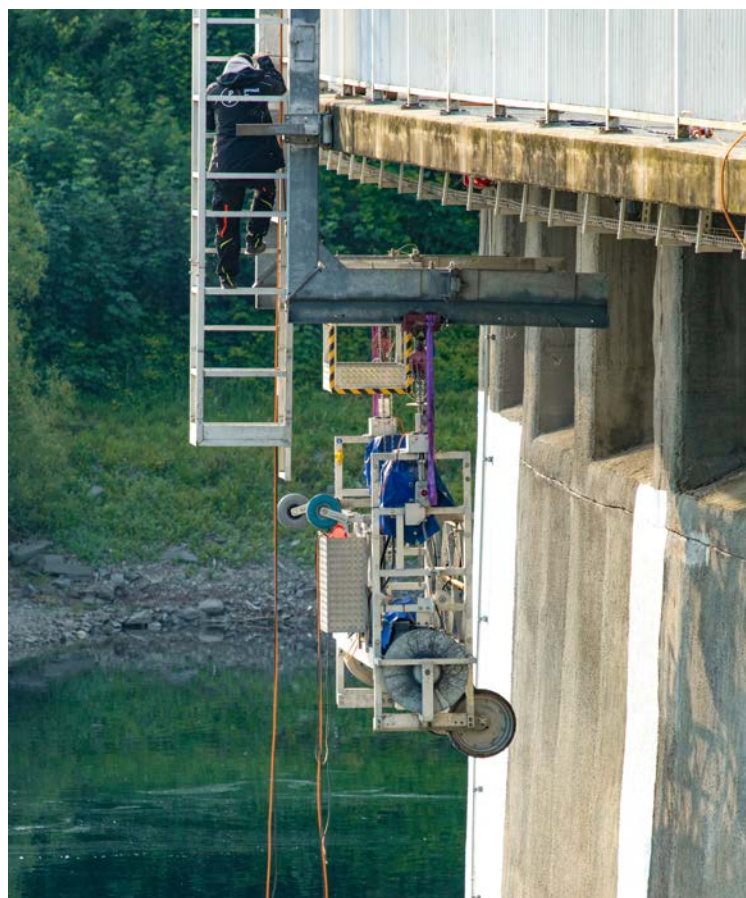
Bauarbeiter befestigen die überdimensionalen Buchstaben an der Staumauer
